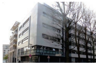
PRÉFA BÉTON CIRÉ CENTRE FINANCES PUBLIQUES RÉALISATION IBATEC
