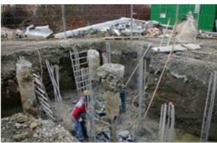
FONDACTIONS SUR PIEUX RÉALISATION IBATEC
