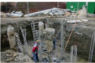
FONDACTIONS SUR PIEUX RÉALISATION IBATEC
